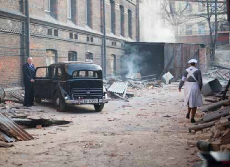
Die Charité ist von Bomben getroffen. Operiert wird nur noch im OP-Bunker
